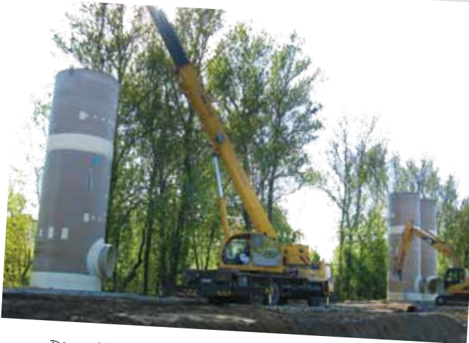
Poços HOBAS DN 3000 para uma confiável descarga de esgoto na Rússia
